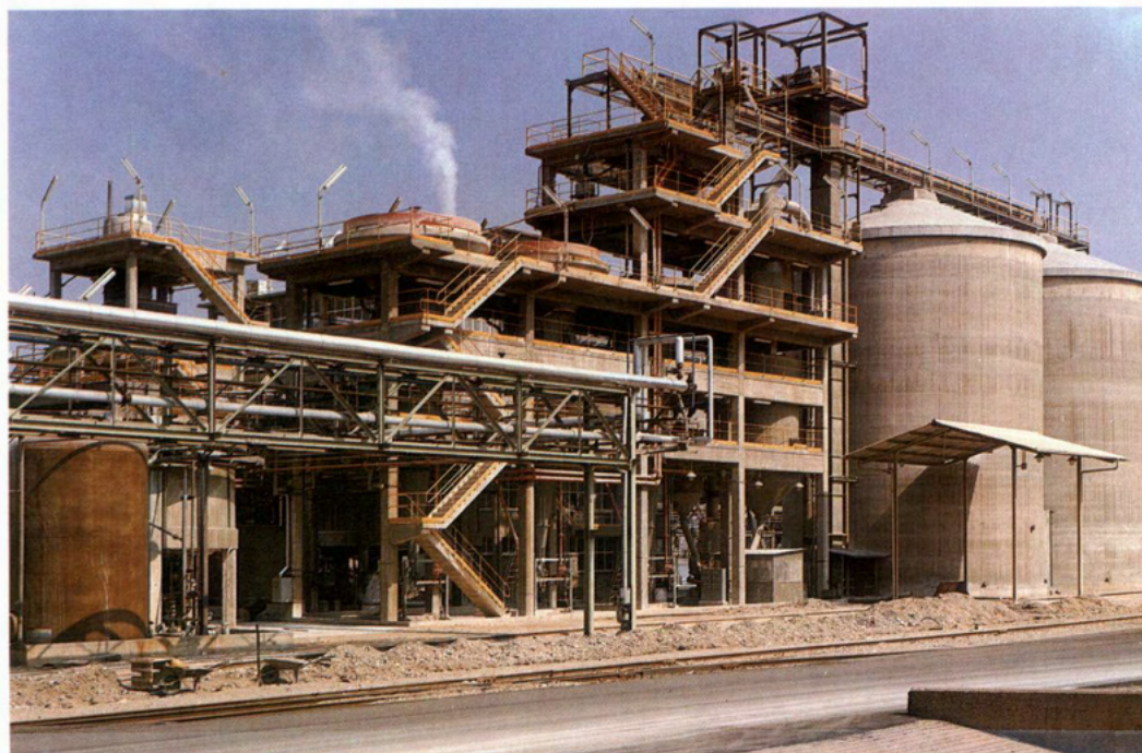
SILOS PARA ALMACENAMIENTO DE LA PLANTA DE FOSFATO BICÁLCICO.
