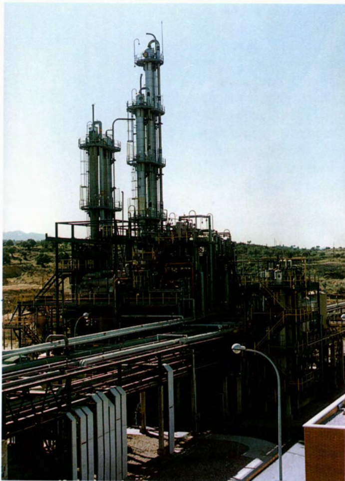
VISTA PARCIAL DE LA PLANTA DE CLOROMETANOS, INAUGURADA EN 1990.
