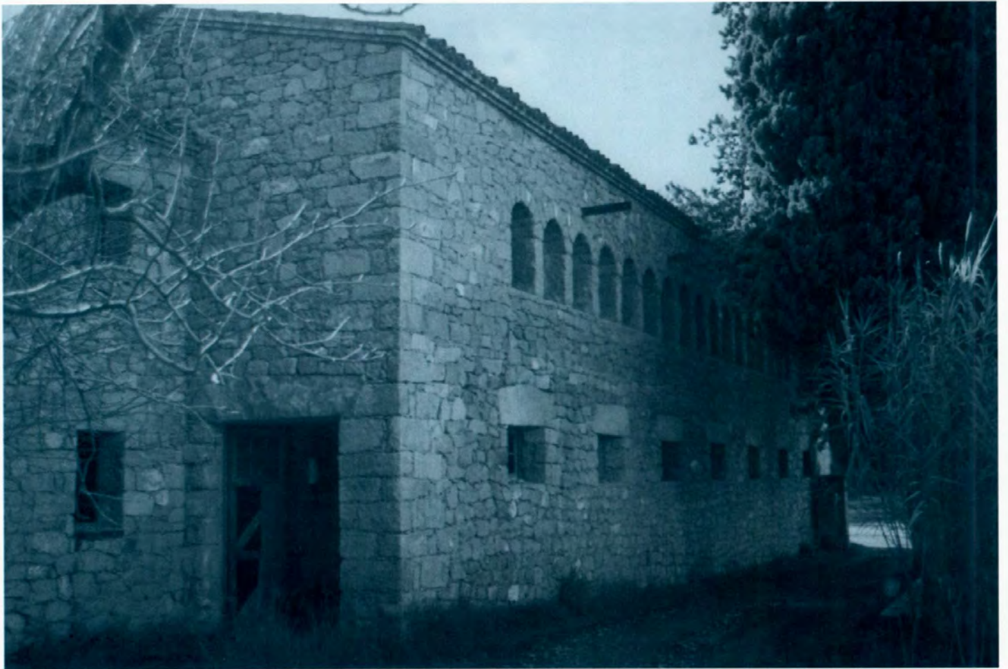
IMAGEN ACTUAL DE LA MASÍA DEL AUBAL
