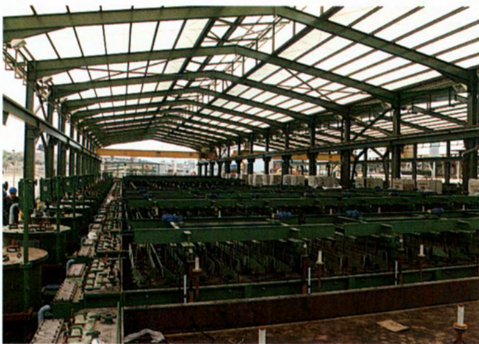
LA INSTALACIÓN DE PRODUCCIÓN DE CLORO EN PROCESO DE REMODELACIÓN, VISTA DESDE LA CARRETERA DE RIBAROJA.
