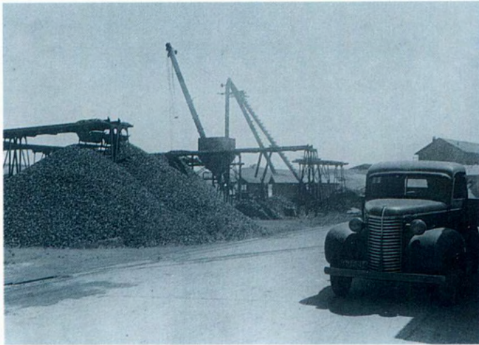
MUELLE DE DESCARGA DE CARBÓN.
