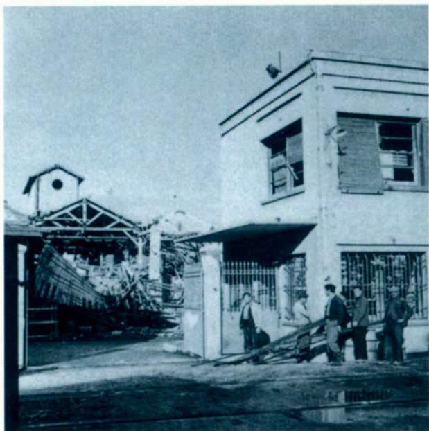
ASPECTO DE ALGUNOS EDIFICIOS DESPUÉS DE UN BOMBARDEO.
