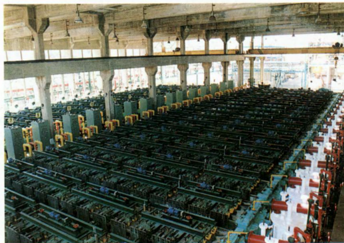
VISTA DE LA PLANTA DE CLOROMETANOS. EN PRIMER TÉRMINO, EL PARQUE DE ALMACENAMIENTO.
