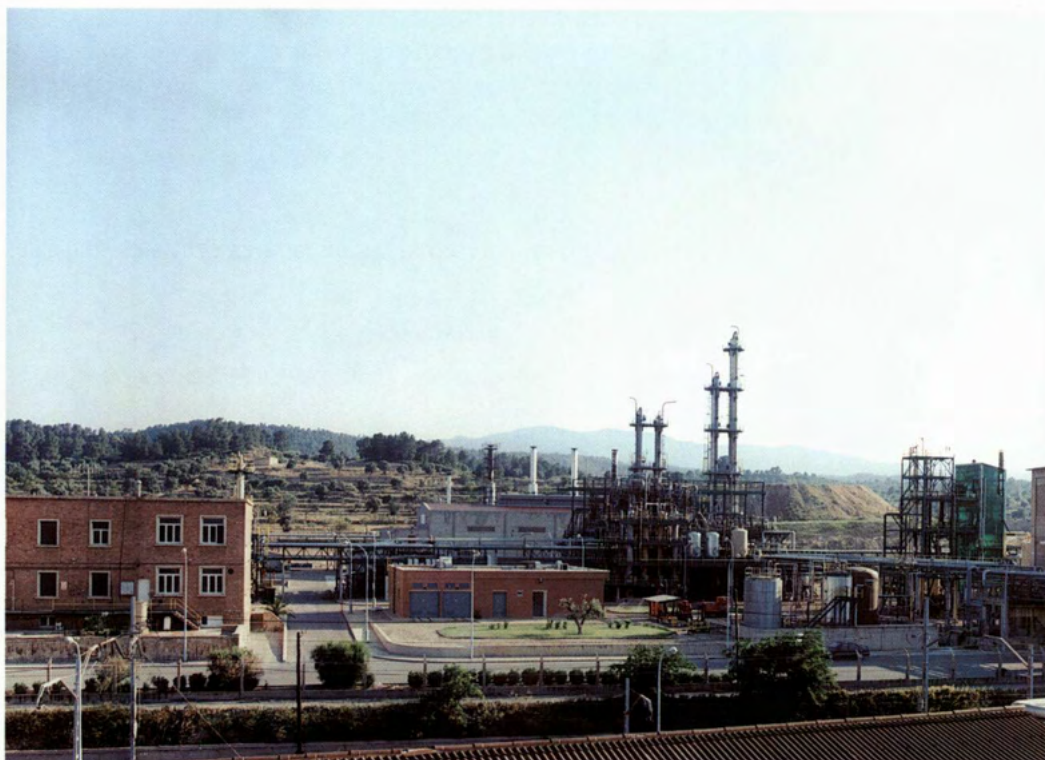
A LA IZQUIERDA, EL EDIFICIO DEL LABORATORIO Y EL CENTRO DE FORMACIÓN; EN EL CENTRO, LA PLANTA DE CLOROMETANOS, Y EN EL FONDO, LA PLANTA DE COGENERACIÓN DE CERE-AIE, INAUGURADA EN 1995.
