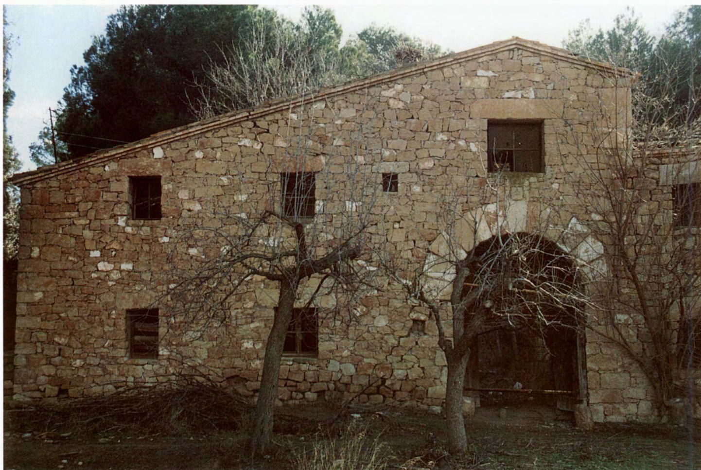
VISTA PARCIAL DE LA FACHADA NORTE DE LA MASÍA, DONDE SE HALLABAN LAS VIVIENDAS DEL MULERO, DEL ADMINISTRADOR Y DEL VAQUERO.
