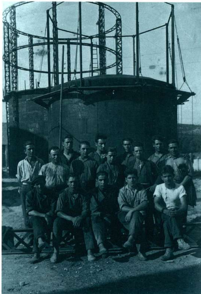
GRUP DE TREBALLADORS A L'INTERIOR DE LA FÀBRICA.
