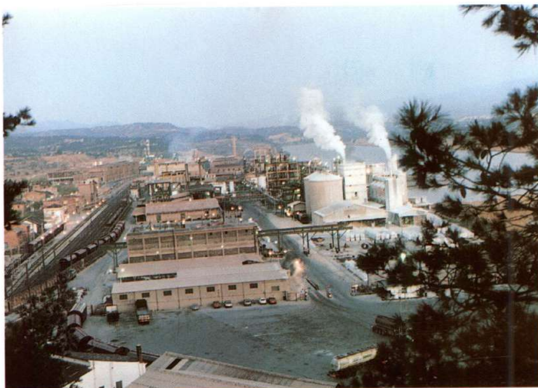
VISTA GENERAL DE LA FÀBRICA A L'ALBA. EN PRIMER TERME, LA PLANTA DE FOSFAT BICÀLCIC.
