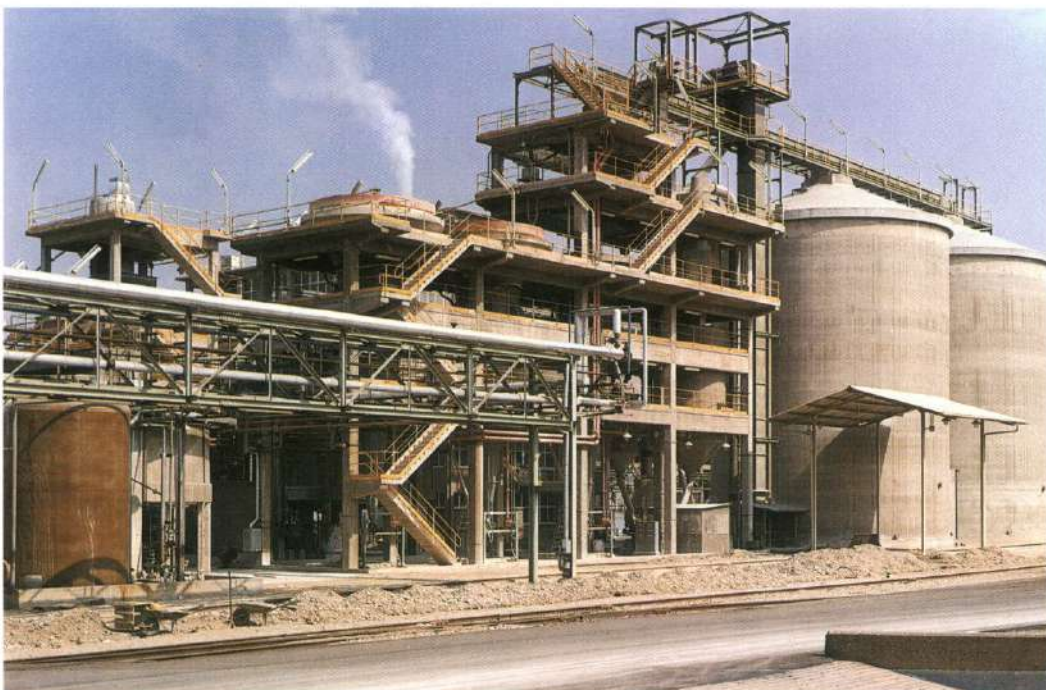
SITGES PER A EMMAGATZEMATGE DE LA PLANTA DE FOSFAT BICÀLCIC.
