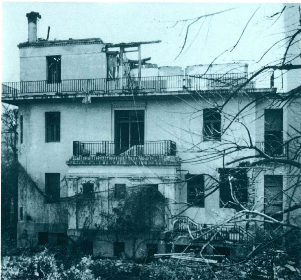
HABITATGES AFECTATS PER LES BOMBES.
