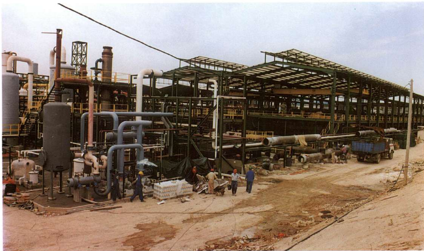
UN PRIMER PLA DE LES OBRES DE REMODELACIÓ DE LA INSTAL·LACIÓ DE PRODUCCIÓ DE CLOR.
