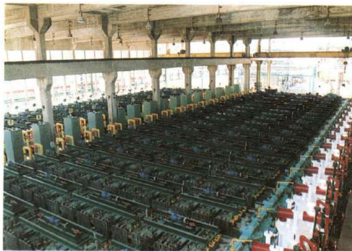
VISTA DE LA PLANTA DE CLOROMETANS. EN PRIMER TERME, EL PARC D'EMMAGATZEMATGE.
