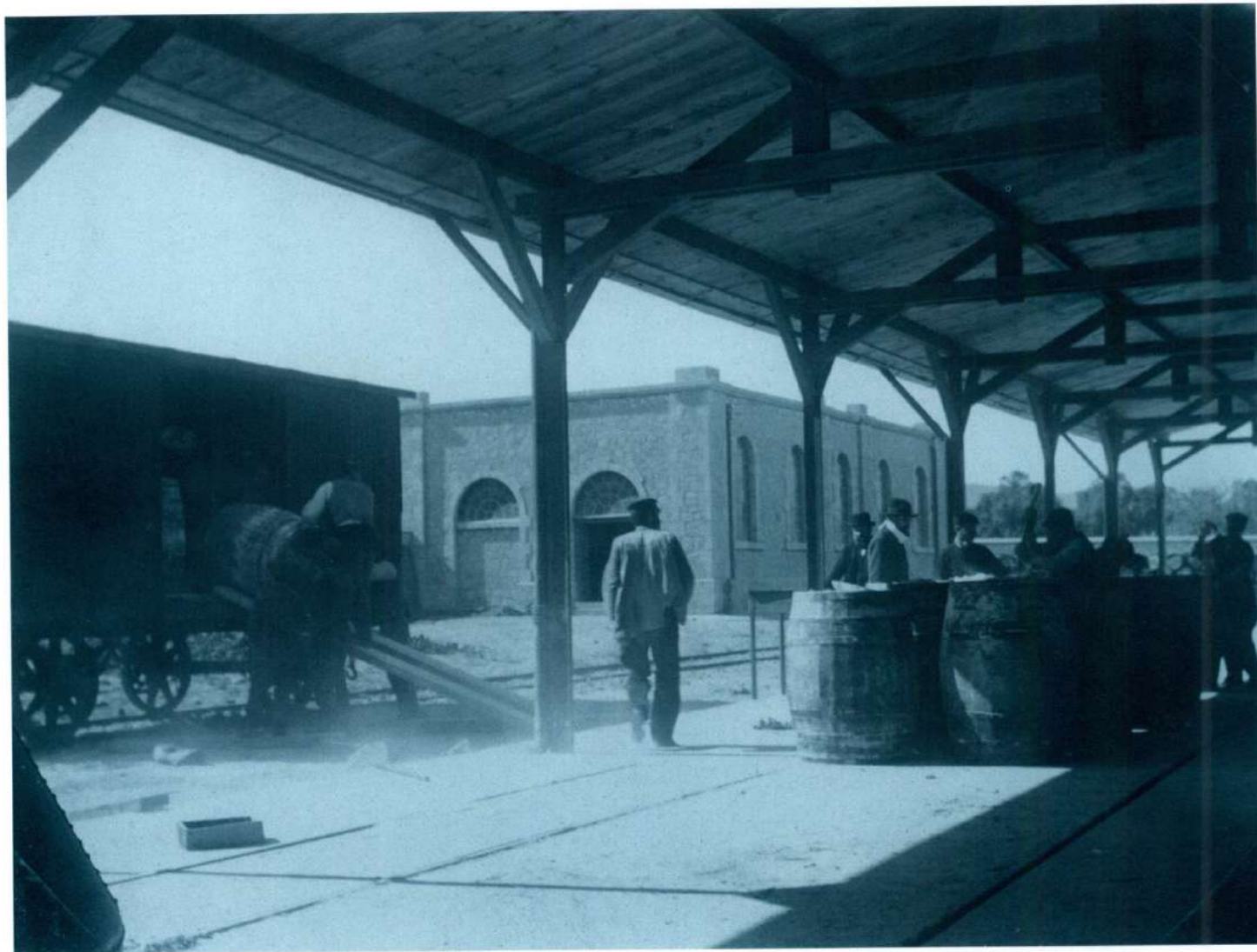
CARREGAMENT DE CLORUR DE CALÇ AL PRINCIPI DE SEGLE.
