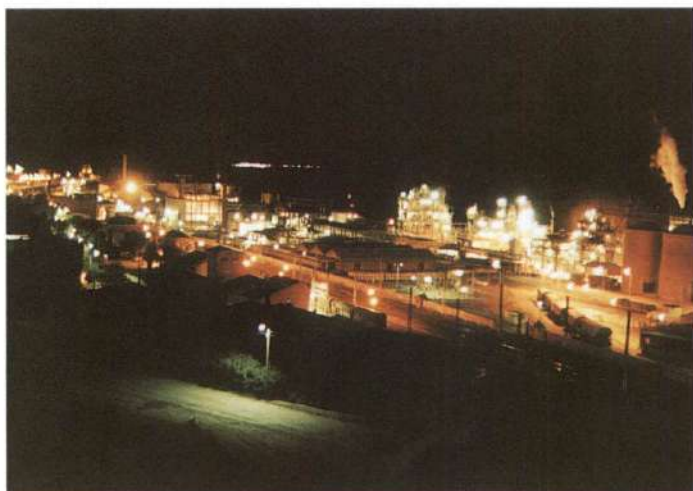
VISTA NOCTURNA PARCIAL DE LA FÀBRICA. AL CENTRE, LA PLANTA DE PERCLORACIÓ I LES CALDERES DE VAPOR.
