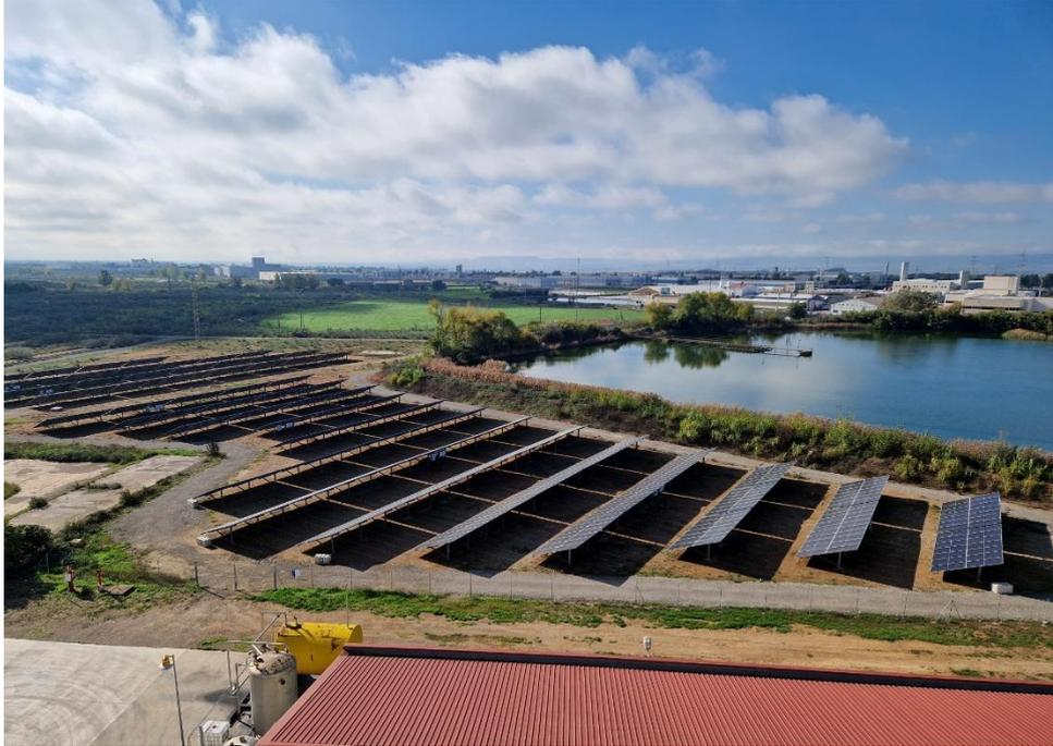
La nueva planta fotovoltaica instalada en la fábrica de Ercros en Monzón (Huesca) permite reducir en 220 toneladas anuales las emisiones de CO<sub>2</sub> de esta fábrica. Su potencia es de 750 kWp y su capacidad de generación, de 850 MWh/año.
