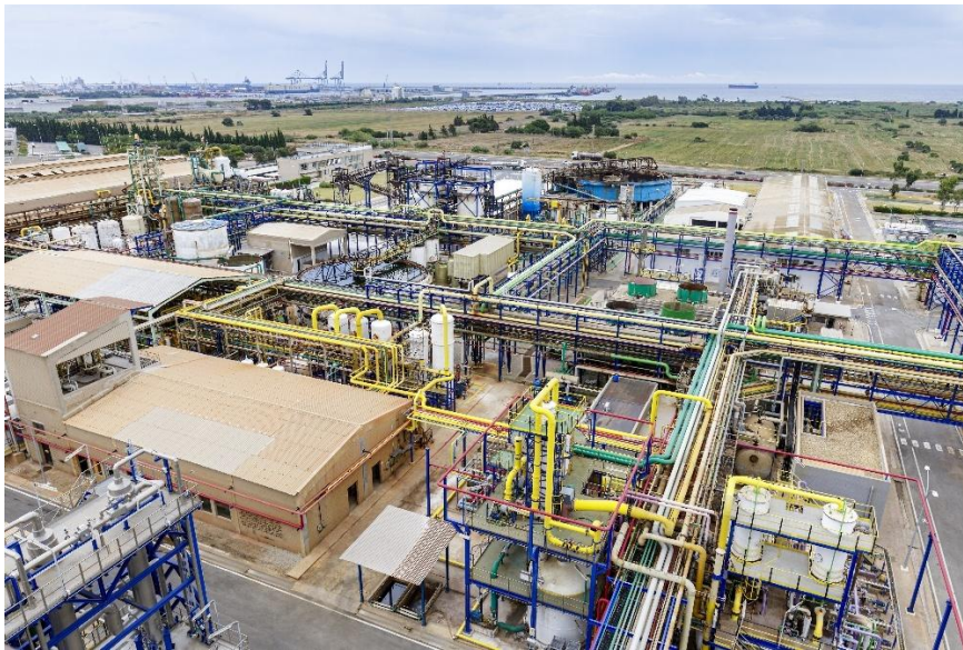
Imagen aérea de la fábrica de Vila-seca I
